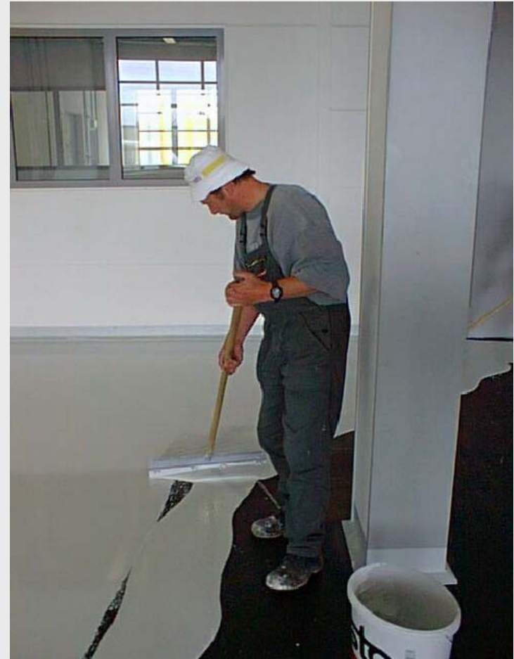
Bild 2: Applikation der Deckschicht StoPox WB 110
