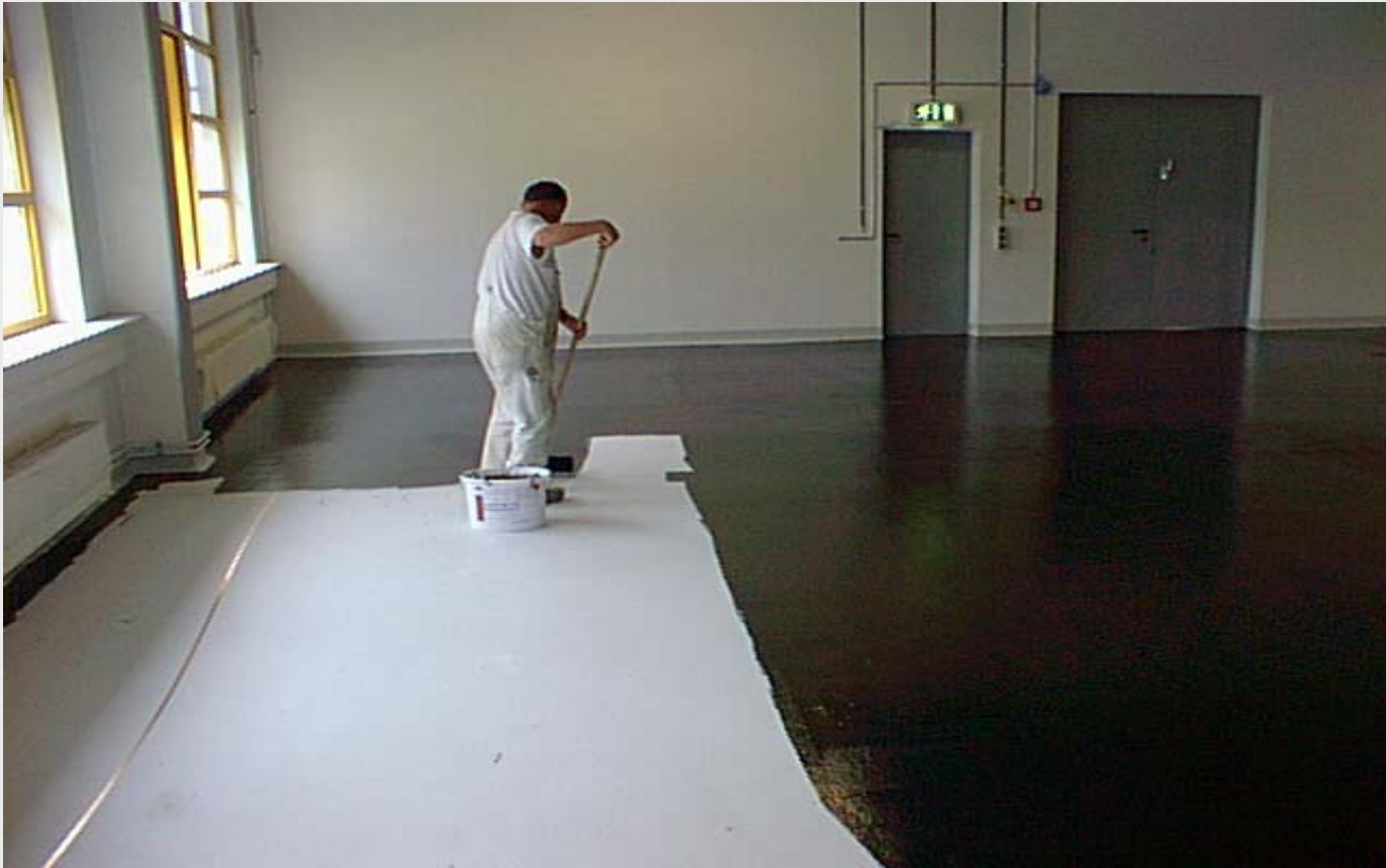
Bild 1: Applikation der Leitschicht StoPox WL 110
